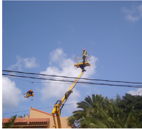
Figura 146. Inspecciones en altura con plataforma elevadora con líneas eléctricas cerca
