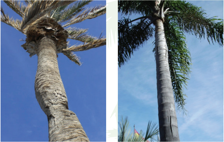
Figura 164 y 165. A la izqda., ejemplar de Phoenix dactylifera “afeitado” hasta la base de la corona, con estrechamientos y fisuras; A la derecha, ejemplar de Syagrus romanzoffiana con fisuras a lo largo del estípite y en distintos puntos
