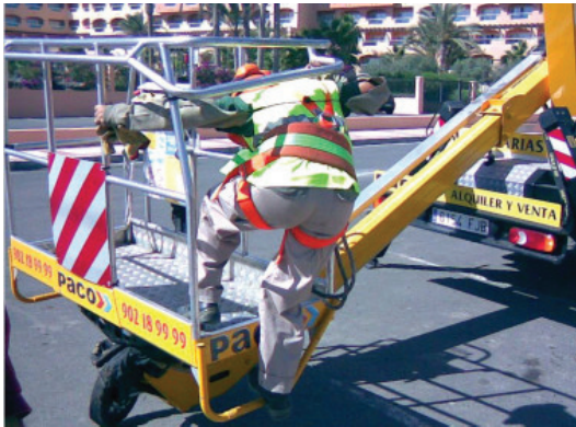
Figura 148. Verificación del estado de la plataforma y operador con equipo E.P.I. para proceder a la elevación
